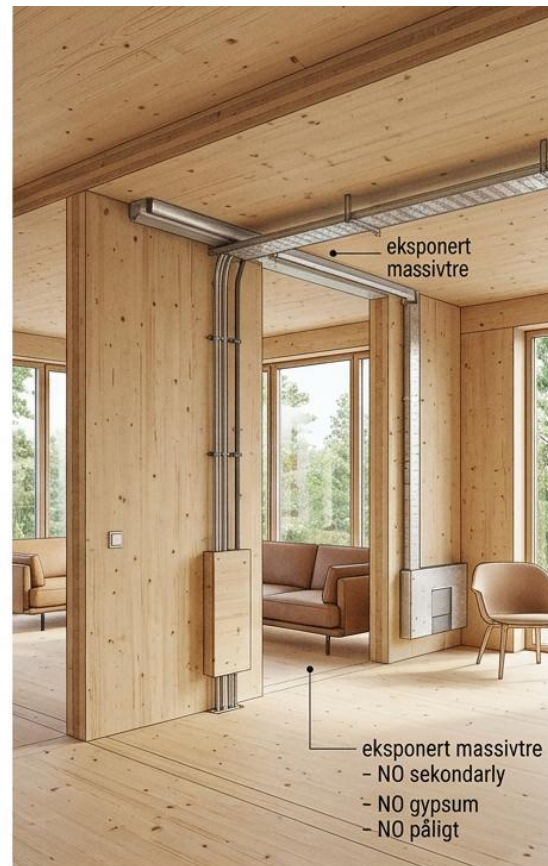
MASSIVTRE – REN OG SYNLIG KONSTRUKSJON
