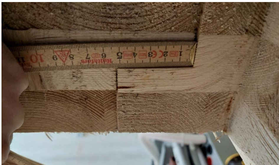
Figur 4-6: Half-lap skjøt [42].
