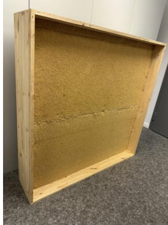
Fig. 4.12: Innerste lag med trefiberisolasjon
