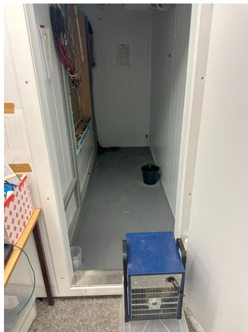
Fig. 4.27: Avriming ved bruk av vifteovn
