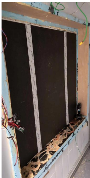
Fig. 4.14: Asfalt med teip over skjøter
